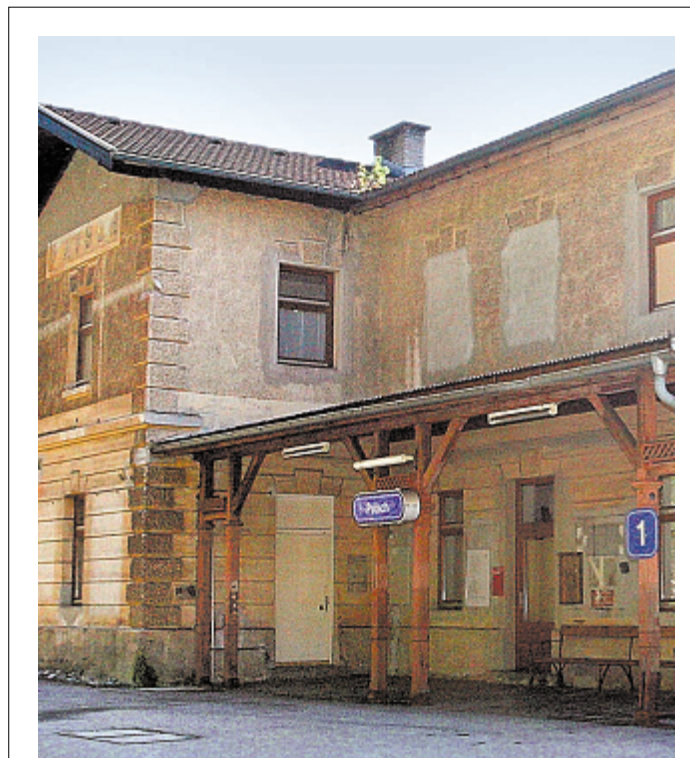
Das Bahnhofsgebäude in Patsch ist schon seit längerem ungenutzt. Die ÖBB möchten es abreißen, das BDA ist dagegen. Foto: Murauer
