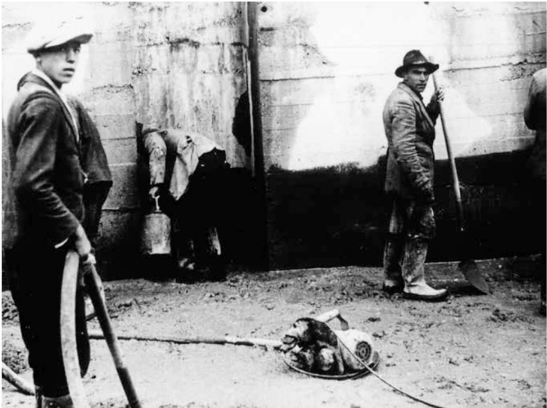
Beim Betonieren der Silvretta-Staumauer leisteten Männer aus den verschiedensten Nationen Zwangsarbeit. (Aufnahme vermutlich 1941/42)
