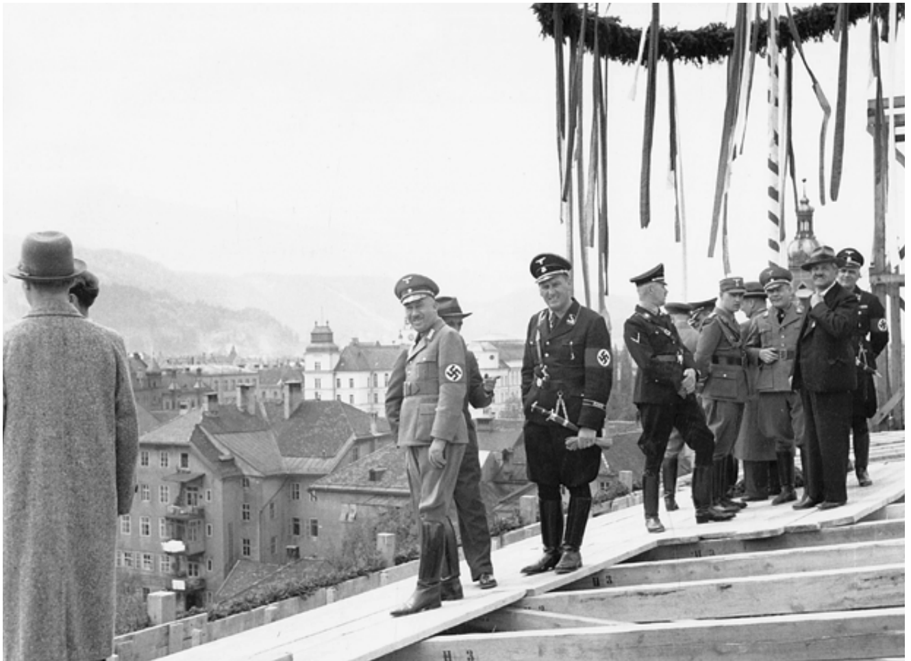
Firstfeier , 6. Mai 1939. Gauleiter Hofer, die lokale Parteilite und Baumeister Hinteregger feiern in Anwesenheit der Bauarbeiter und der Wiltener Musikkapelle den Abschluss des Rohbaus.
