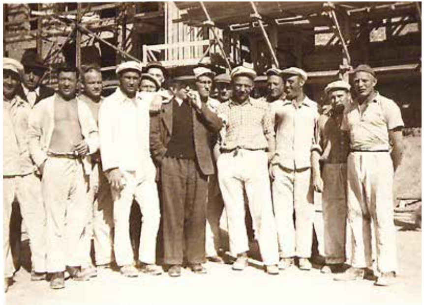
„Münchener Maurer“ auf der Baustelle, April 1939. Neben einheimischen Bauarbeitern kommen Männer aus dem Deutschen Reich und aus Italien zum Einsatz.
