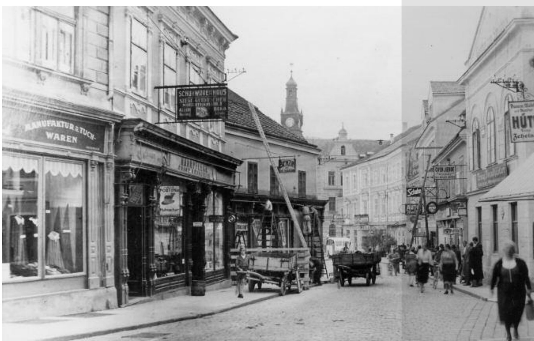
Arisiertes Kaufhaus Greger beim Abbruch im September 1938
