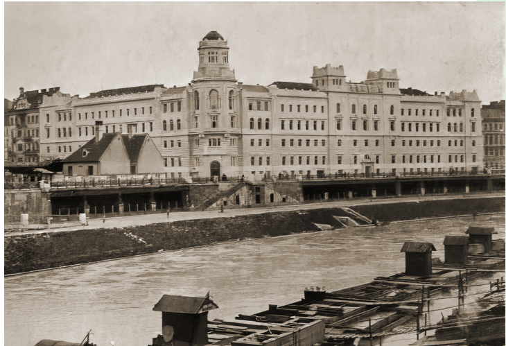
Polizeigebäude an der Rossauer Lände in Wien, 1904 (Bibliothek im Rathaus, Signatur B 103785)
