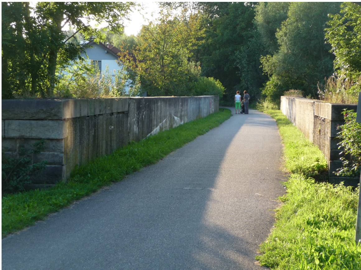
Ehemalige Schlepplbahntrasse – Brücke über die Gusen
