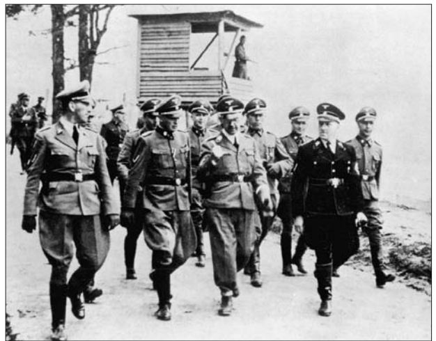
Inspektion Kaltenbrunner, Ziareis, Himmler Eigruber auf dem Weg zum Wienergraben (SS-Foto)
