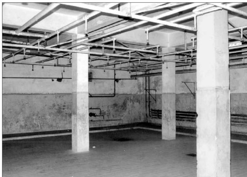
Duschraum im Keller der Wäschereibaracke
