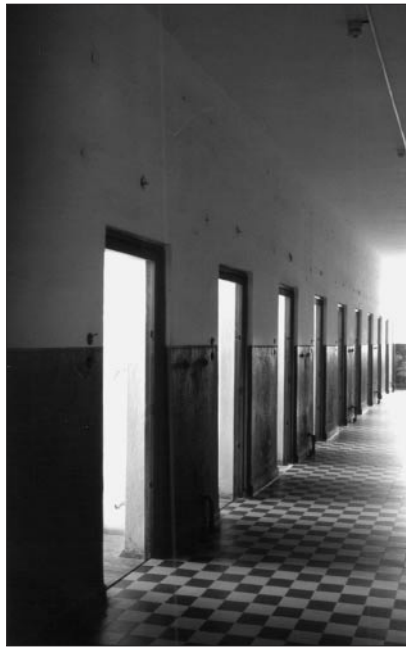
Lagergefängnis („Bunker“) - Zellentrakt
