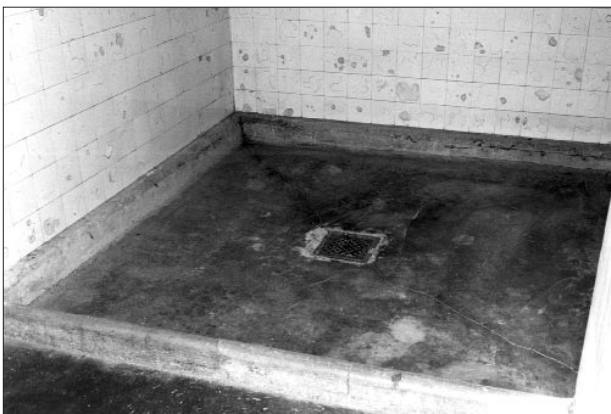
Leichenraum - Boden mit Abfluß
