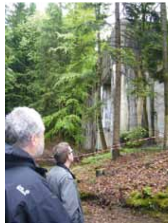
Reste der Bunker für Triebwerkstests
