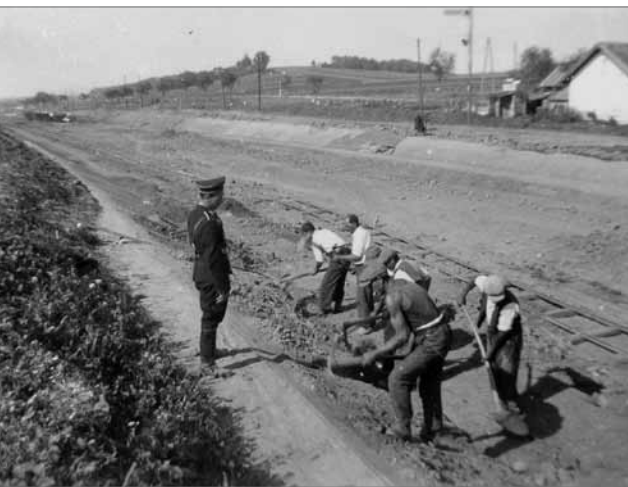
Roma bei der Zwangsarbeit 1940 beim Straßenbau zwischen Pinkafeld und Oberwart
